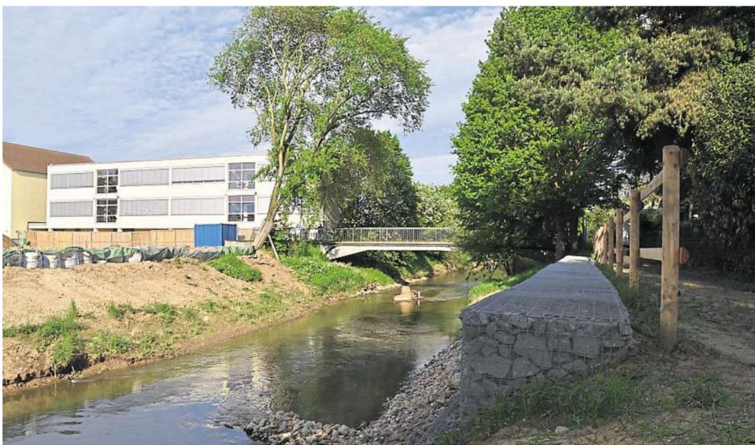
Der innerörtliche Bereich der Weschnitz wird derzeit umgestaltet. Als konkrete Maßnahmen werden ein Weg auf der Nordseite der Weschnitz (rechts) sowie eine Sanierung oder Verlegung des Schulstegs vorgeschlagen.
